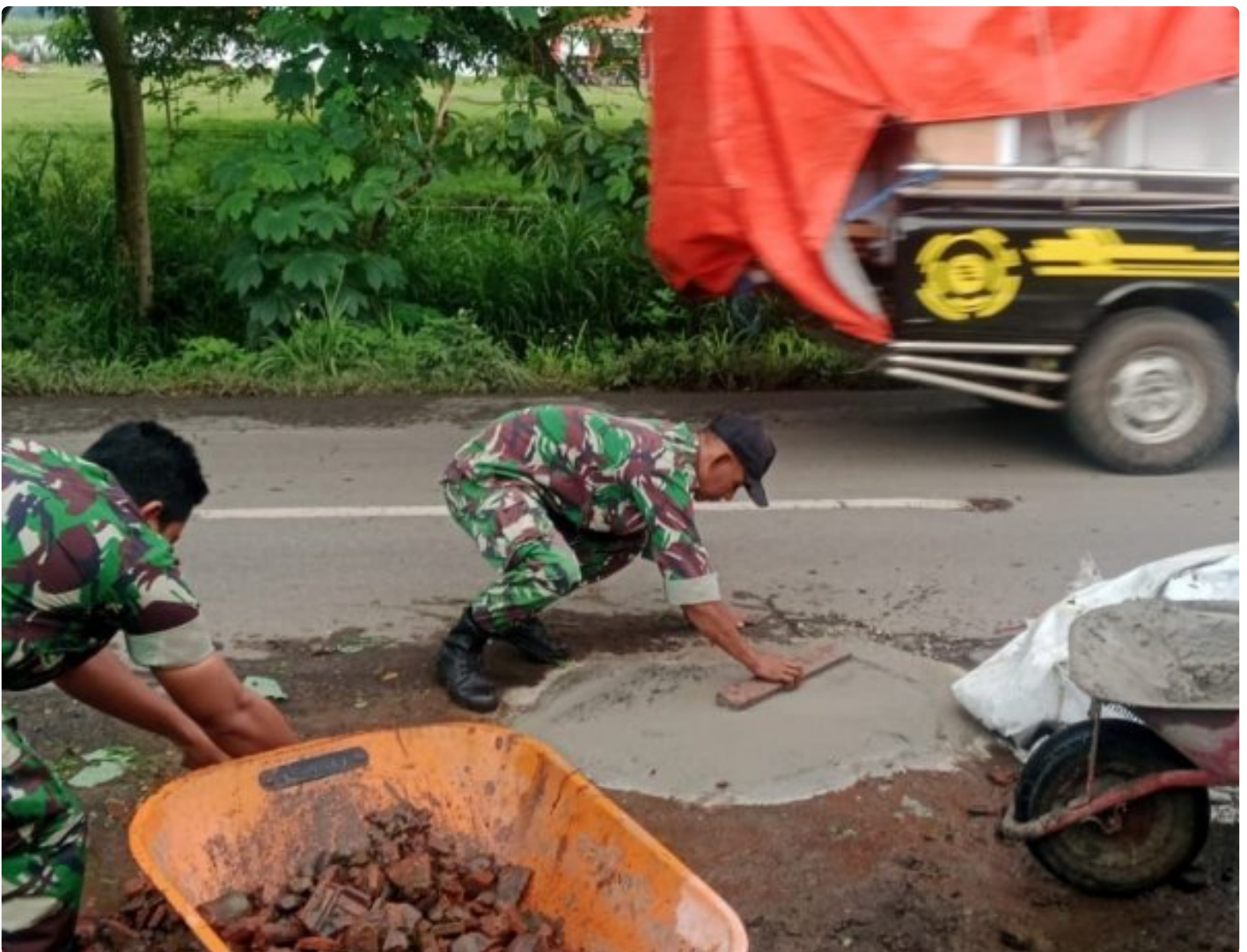
Demi Keselamatan Pengguna Jalan, Anggota Koramil 0804/13 Bendo Kerja Bakti Perbaiki Jalan Yang Berlubang
